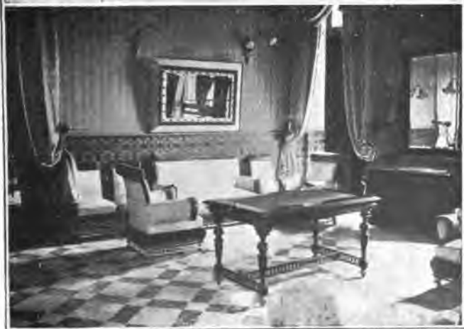
I. Fachada principal.—II. Saloncillo del casino.
