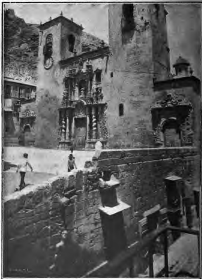
Fachada de la iglesia de Santa María.
