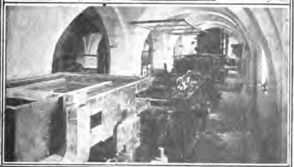
Vista de la fábrica é interiores.
